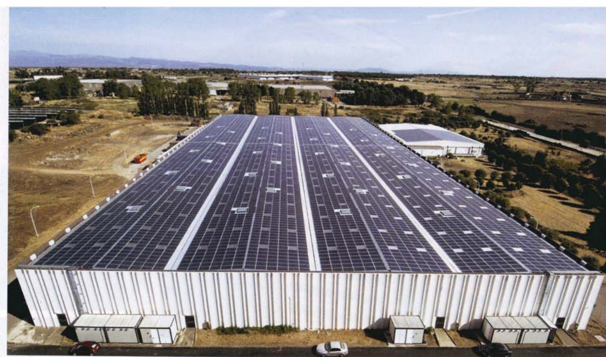
IMPIANTO FOTOVOLTAICO CON SMALTIMENTO AMIANTO
