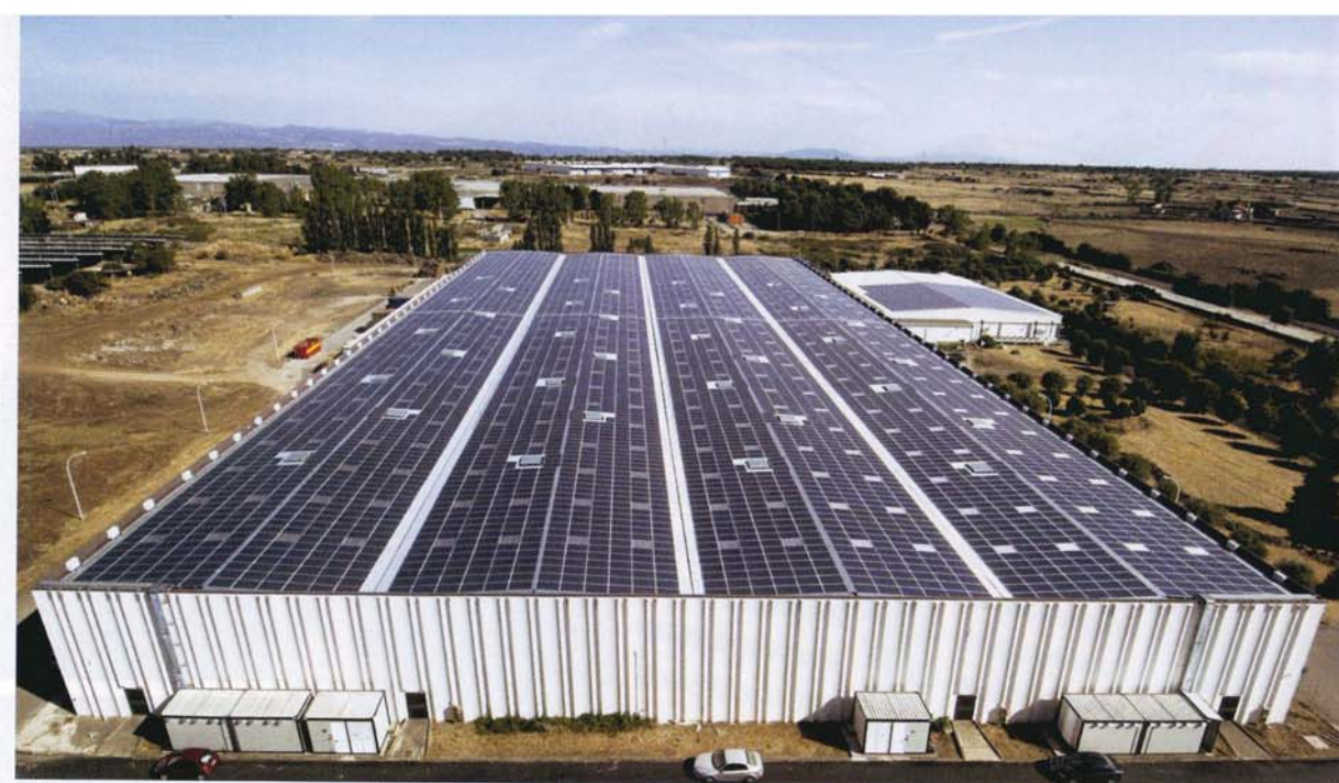
IMPIANTO FOTOVOLTAICO CON SMALTIMENTO AMIANTO
