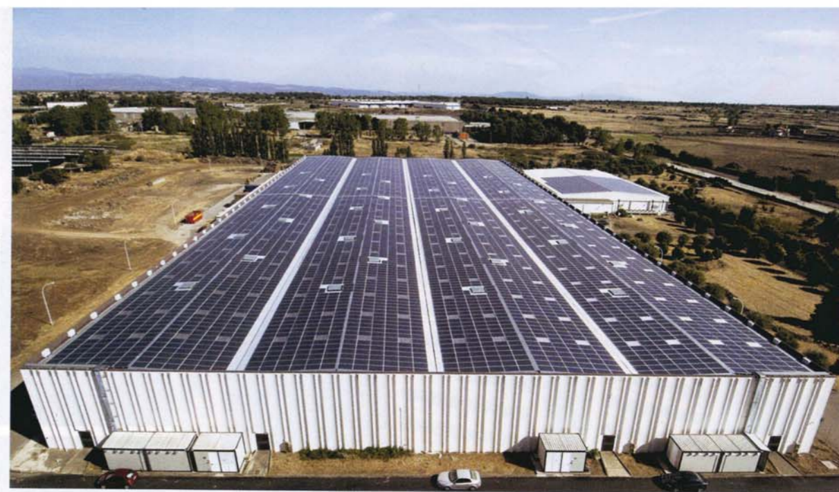
IMPIANTO FOTOVOLTAICO CON SMALTIMENTO AMIANTO
