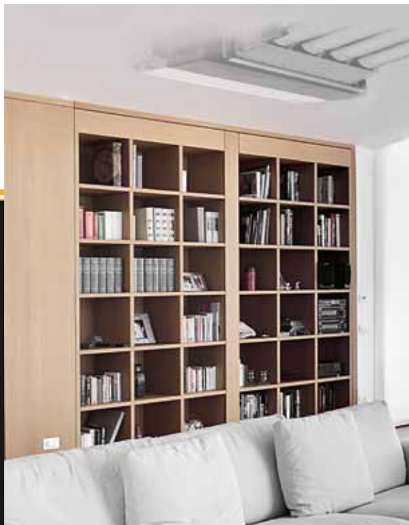
IL SISTEMA CANALIZZATO PER RISCALDAMENTO E RAFFRESCAMENTO AD ARIA INSERITO NEL CONTROSOFFITTO
