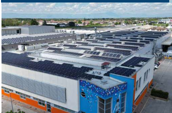
A partire da sinistra impianto fotovoltaico di 437,27 kWp, impianto fotovoltaico di 180 kWp, n.3 pompe di calore aria-acqua BWHE281 in cascata.
