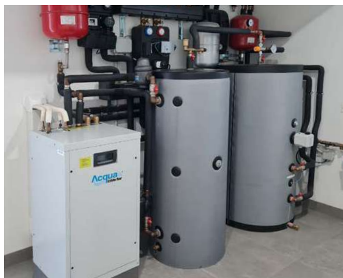
Impianto con pompa di calore AcquaInverter® modello WM15 con n.2 unità esterne completata con Volano termico per acqua refrigerata e di riscaldamento WACN da 200 litri e un accumulo termico di acqua calda sanitaria WBX da 300 litri integrato al solare termico. L'impianto è stato integrato con solare fotovoltaico da 8,68 kWp.
