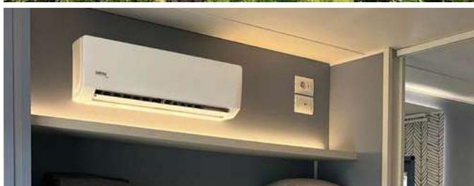
Le mobil-home de luxe a inclus l'installation de systèmes de pompe à chaleur monosplit modèle Syntek Shine, prolongeant le confort même à la mi-saison grâce à l'utilisation des fonctions de chauffage, de froid et de déshumidification.
