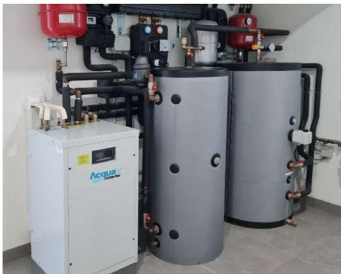
Système avec pompe à chaleur AcquaInverter® modèle WM15 avec 2 unités extérieures complétées par un volant thermique WACN de 200 litres pour l'eau glacée et chauffée et un ballon de stockage thermique d'eau chaude sanitaire WBX de 300 litres intégré au système solaire thermique. Le système a été intégré à un système solaire photovoltaïque de 8,68 kWc.
